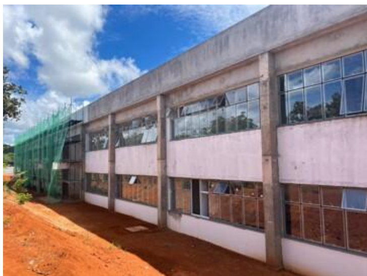
Figura 9. Obra da FAV.
